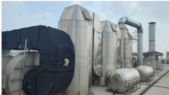
涂布烘烤废气排气筒
