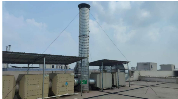
涂布烘烤废气排气筒
