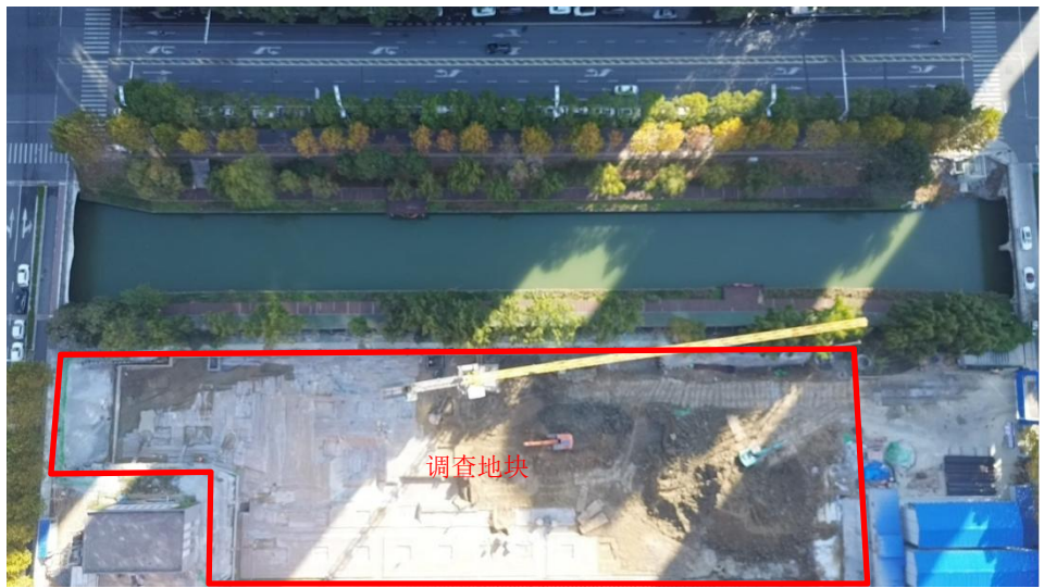
地块南侧航拍图 (南宁路, 隔南宁路为保利海上五月花小区)
