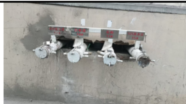
筒仓投卸料口
